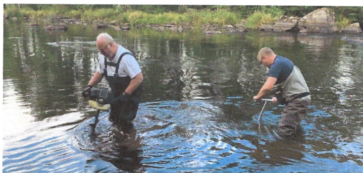
Bild 2. Arbete med motorjordborr är effektivt för att underhålla lekbottnar.
