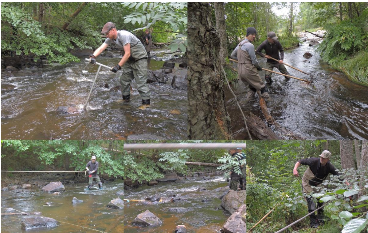
Bild 3. Övre raden: Arbetet med Hartijokiverktyg, tv uppluckring av botten, th; iläggning av tidigare upplagda stenar. Nedersta raden: Bogsering av block med motorvinsch.
